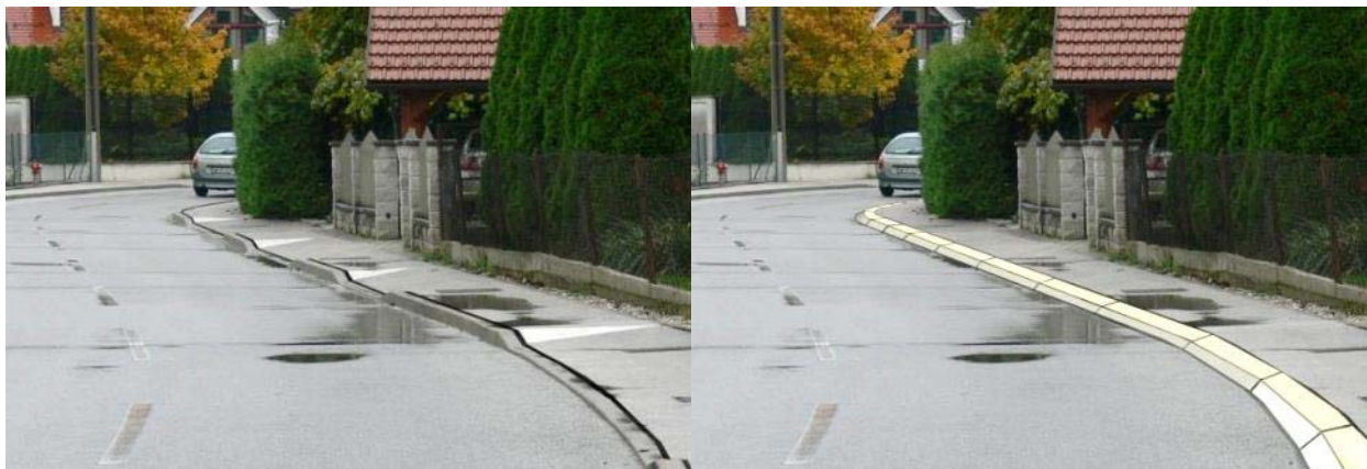
Slika 30: Trenuten pešcem neprijazen (valovit) pločnik (levo) in predlog nižanih pločnikov s posnetim robnikom (desno) Vir: UM FGPA
